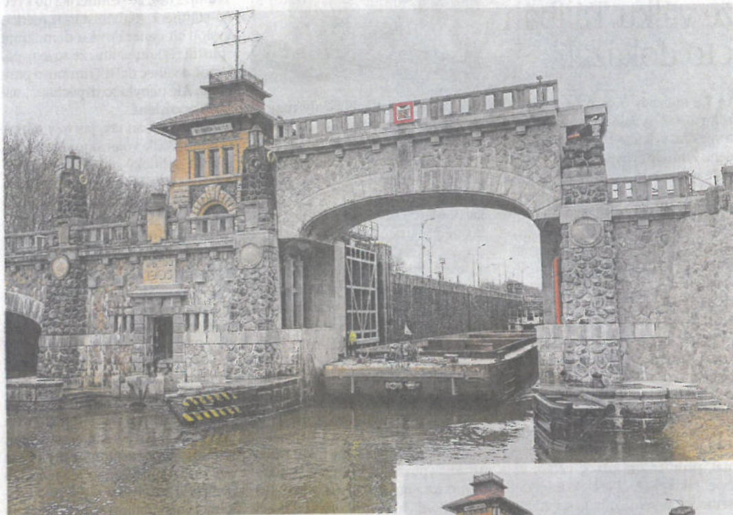
Unikát Most ve zvednuté poloze umožní lodím proplout (nahore) a pak klesne (dole). 2x foto: Pavel Svačina, MAFRA
