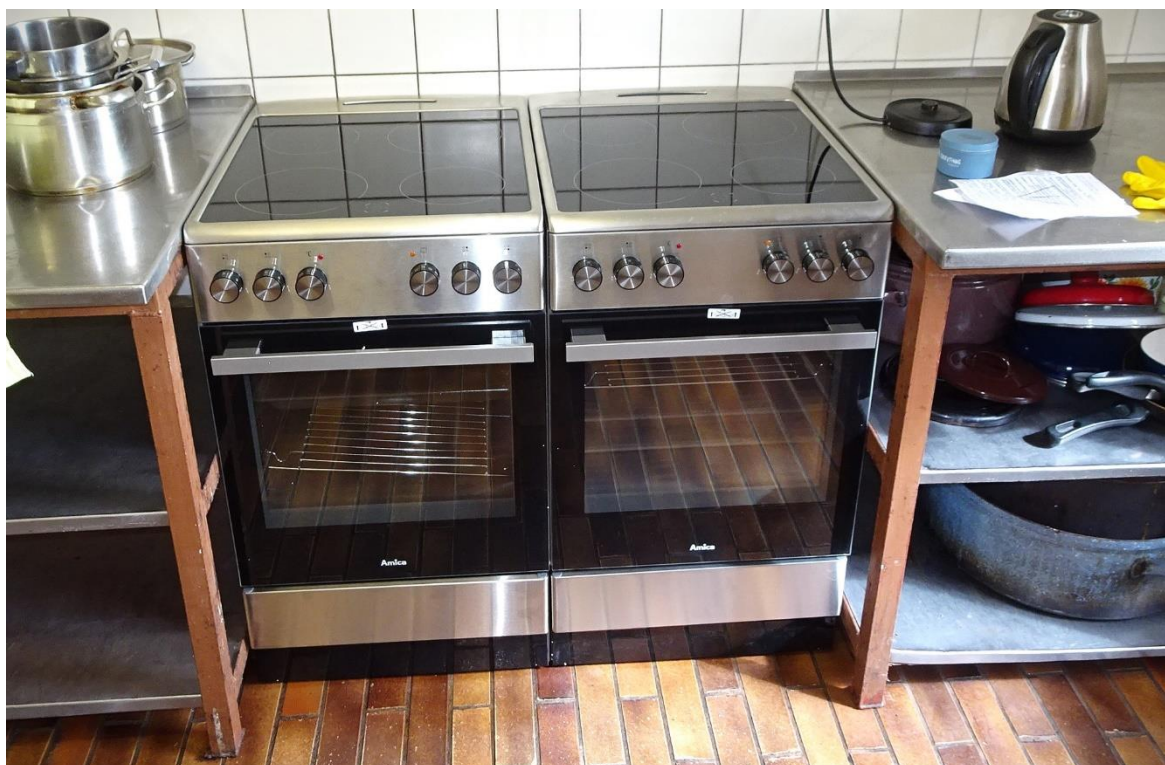
Na Hutích došlo během brigády k výměně sporáků. Tak ať nám dlouho slouží!
